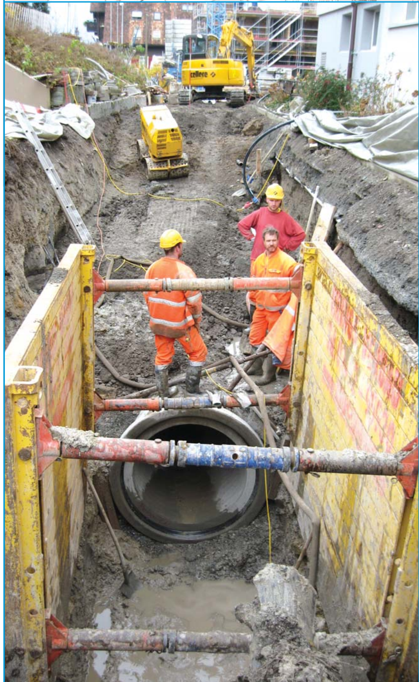
Ein beträchtlicher Teil der neuen Leitung wurde bereits erstellt (Bild oben). Die Betonrohre weisen auf einer Gesamtlänge von rund 250 Metern Durchmesser zwischen 1000 und 1400 mm auf.
