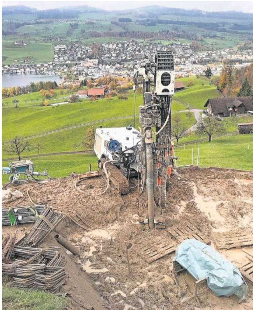
Unterhalb des «Alpenhofs» wird mit einem Mikrobohrpfahl gearbeitet (links), eine erstellte Stütze (oben rechts) und das Fundament im Waldgebiet zeigen den Baufortschritt der geplanten neuen Bahnanlage Küssnacht-Seebodenalp.
